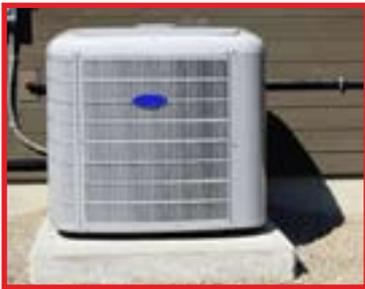
إن مبدأ عمل مضخات الحرارة هو نقل الطاقة الحرارية بين وسطين معزولين حراريا باستعمال الطاقة الكهربائية دون أن تساهم هذه المضخة في الميزان الطاقوي للوسطين. ويمكن أن تعمل هذه المضخة في الاتجاهين من دون مشاكل، وبالتالي فإن نقل الطاقة الحرارية من الوسط الأول الى الوسط الثاني ينجم عنه انخفاض درجة حرارة الوسط الأول وارتفاع درجة حرارة الوسط الثاني.
